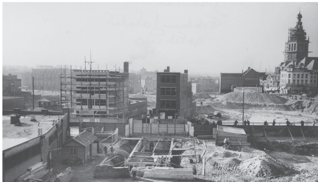
Foto: De herbouw van enkele winkelpanden, geheel rechts de St. Stevenstoren in de steigers, 1952.
